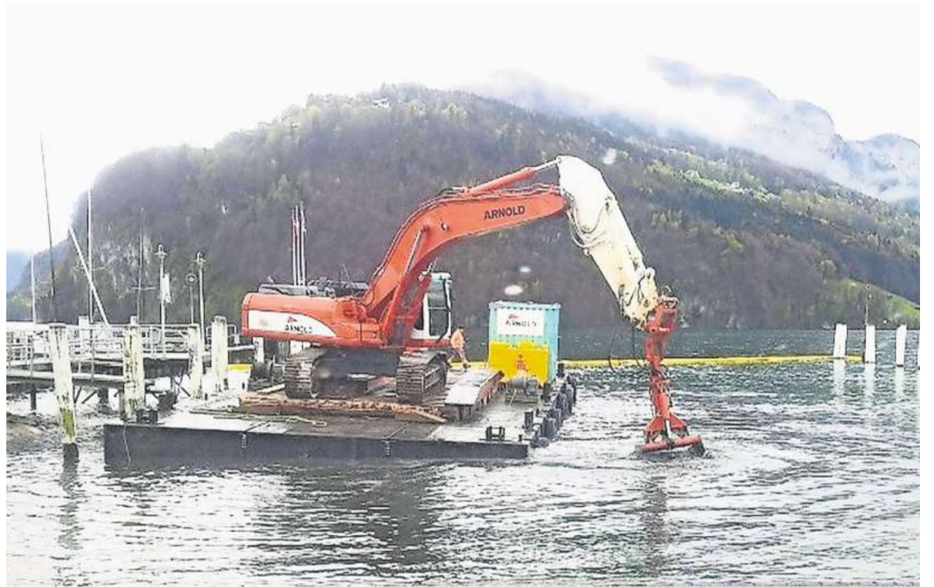
Im Frühjahr 2014 arbeitete ein Bagger im Föhnhafen Brunnen.
